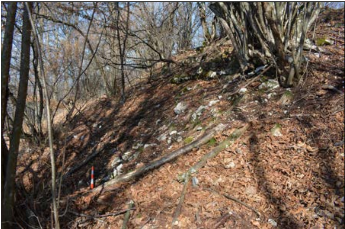
Sl. 34: Sv. Jakob nad Potočami. Obzidan prehod med podpornima zidovoma južno od objektov G in A. Pogled proti severozahodu (DSC 7718; 12. 3. 2020; foto: Andrej Gaspari)
